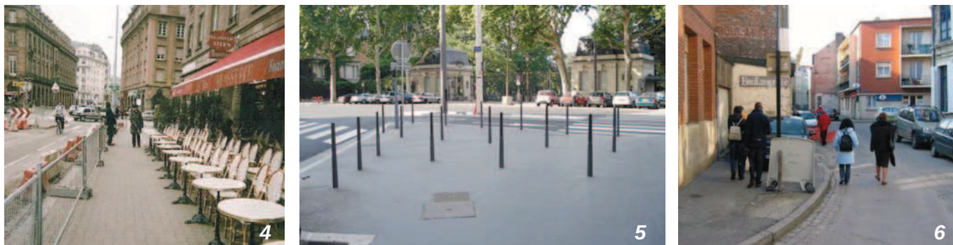
Exemples d'équipements et mobiliers urbains pouvant faire obstacle sur voirie : 4 - terrasse de café, 5 – potelets devant abaissé de trottoir, 6 – panneau de travaux rétrécissant le passage sur trottoir.
