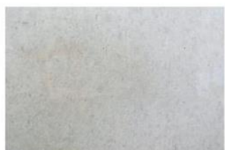
BETON LISSE BRUT
