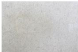
BETON LISSE BRUT
