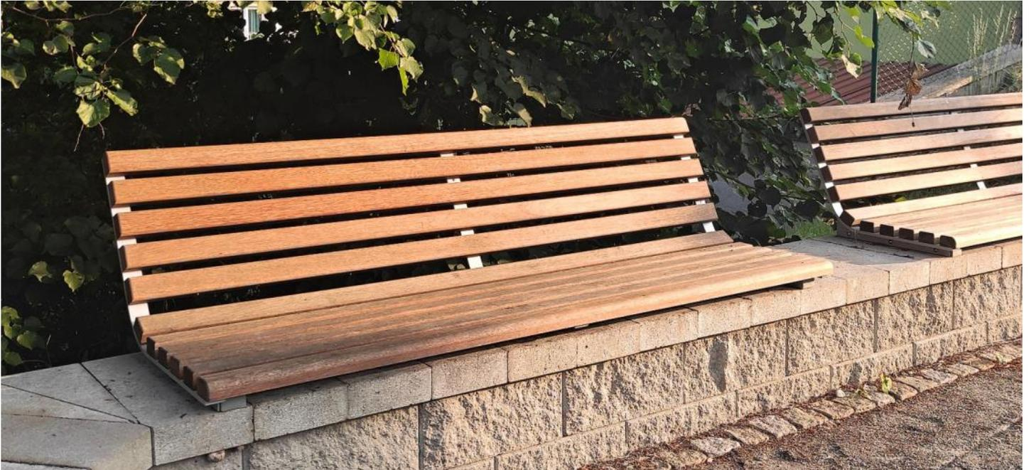
**Description** : Structure en acier galvanisé. L'assise et le dossier sont composés au total de 11 lames de bois de dimension 56x32x1800mm. La plus haute des lattes du dossier et la dernière lattes de l'assise sont arrondis. La structure se fixe au mur existant avec des pièces en acier de dimension 50x25mm
