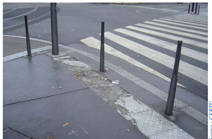
Exemple de détérioration d'une BEV.
