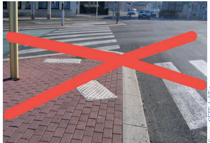
Mauvaise implantation de BEV.
