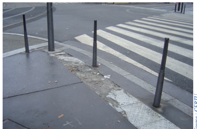
Exemple de détérioration d'une BEV.
