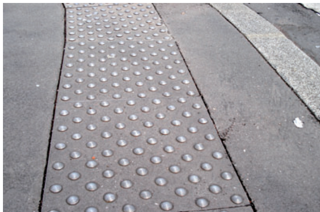
Exemple de produit hétérogène (clous inox sur semelle en asphalte).
