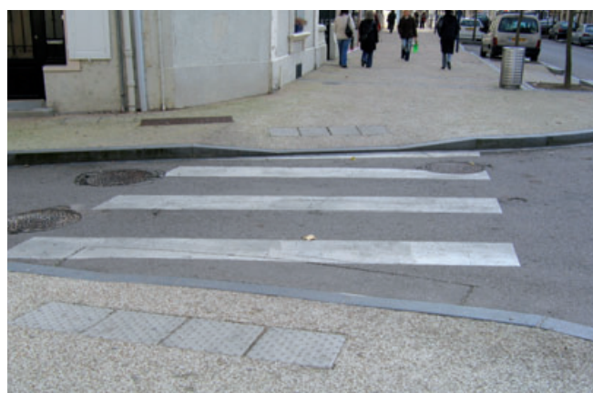
BEV implantées dans un carrefour à voies perpendiculaires.
